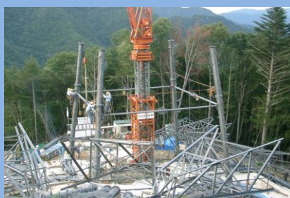
鉄塔組立工事
